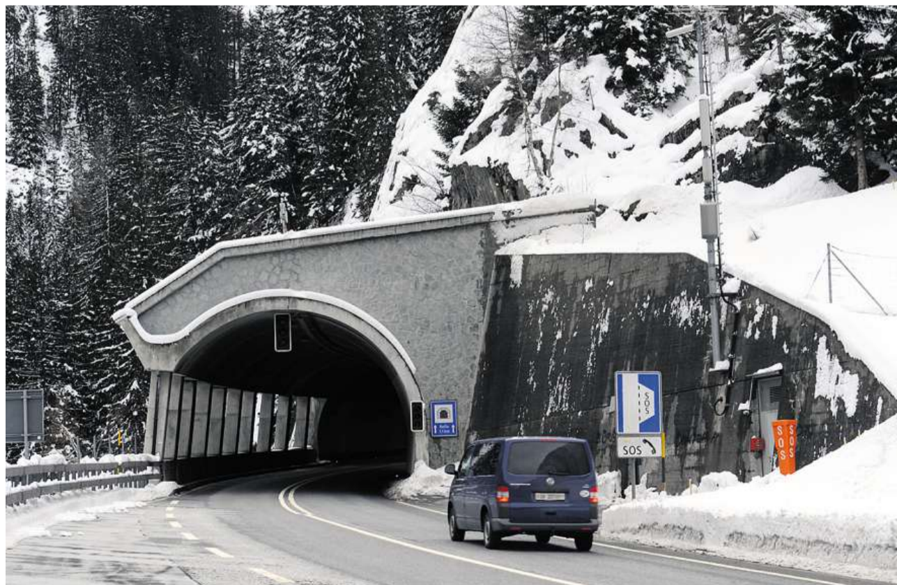
Mehr Sicherheit für die Verkehrsteilnehmer: Der 1,1 Kilometer lange Rofla-Tunnel zwischen Andeer und Sufers wird mit einem Sicherheitsstollen ausgestattet. Bild Theo Gstöhl
